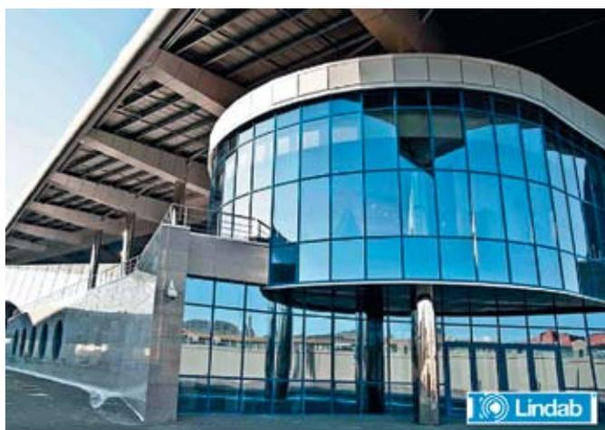
Здание построено на основе металлических конструкций Lindab. Одна из его особенностей – нестандартная арочная фальцевая кровля площадью 6,4 тыс. кв. м с вентилируемым подкровельным пространством. Функциональный, комфортный, с динамичным архитектурным образом – каток соответствует всем международным стандартам.
